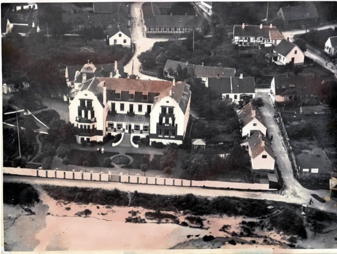
Fig. 13. Strandslot ses direkte fra nord. Man bemærker verandabygningen fra 1922 med den lige front samt de to (stadig eksisterende) trapper. Strandpromenaden er anlagt. Til højre for hotellet ses to huse (hver med et vindue i gavlen). Det er Strandstræde 2 til 8. I 1916 købte Helene Reiner nr. 2 og i 1919 købte Hans Reiner nr. 6. Det er halvhusene (fjerneste ender) af de to nævnte huse. I 1933 købte Helene Reiner endvidere halvhuset Strandgade 22, som på billedet ses lige syd for Strandstræde 2 (med tilsødet skorsten). Hotel Strandlyst (Rosenborg), som Hans Reiner købte i 1913, er beliggende umiddelbart uden for billedfeltet foroven til venstre. Luftfoto Eskild Fut Jensen, 1929. Ø-arkivet i Rønne
