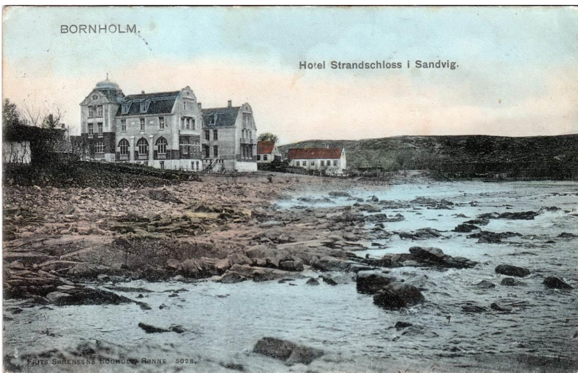
Fig. 1. Det nybyggede Kurhaus Strandschloss set fra nordøst. Matriklens omkransende mur er endnu ikke opført. Fløjenes murværk er gråt. Den nederste altan i østfløjens nordgavl er lukket med mørkt træ ("klædeskab"). Under denne skyder kælderens køkkenvinduer frem. Mellem fløjene var
