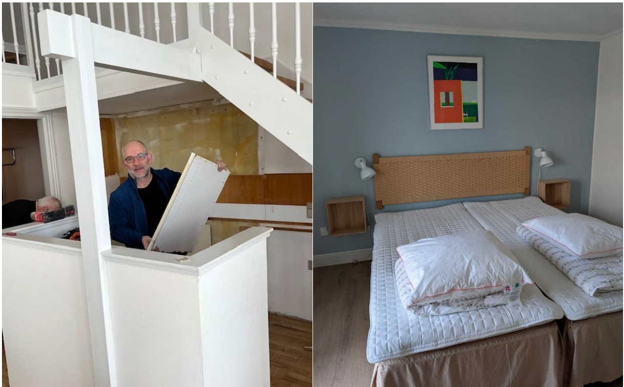
Ejendomsinspektør Ulrik Andersen hjalp med at nedbryde køkkenet i lejlighed 2. Og til højre ses den nye stil i Strandslots soveværelser.
